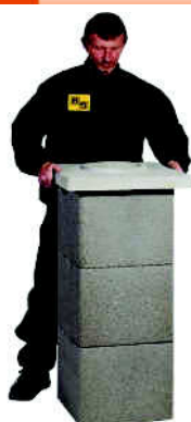
obr. 14 Osazení betonové krycí desky
