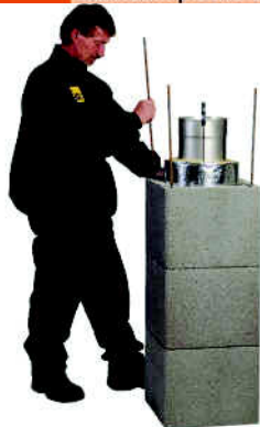
obr. 13 Vyztužování komínu v nadstřešní části ocelovou výztuží
