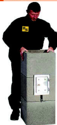
obr. 3 Vyřezávání otvoru pro základní nahlížecí díl
