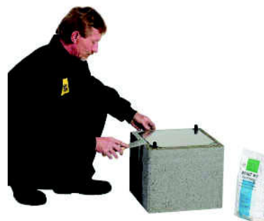
obr. 4 Nanášení lepidla BOTACT M19 na komínovou tvárnici
