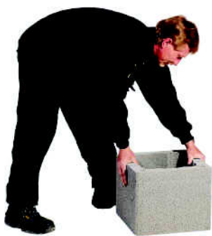
obr. 1 Osazení první komínové tvárnice na základ opatřený izolací proti zemní vlhkosti
