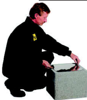
obr. 2 Osazení nosného plechu na první komínovou tvárnici
