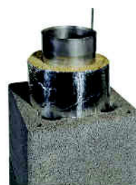
obr. 8 Vložení izolace ROCKWOOL do komínového tělesa
