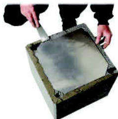
obr. 5 Osazení spojovacích kolíků a nanášení lepidla do spáry
