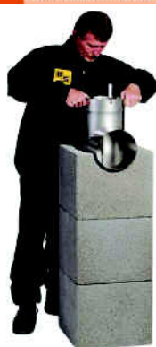
obr. 6 Osazení nahlížecího dílu s nádobou na odvod kondenzátu
