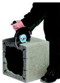
obr. 3 Vyřezávání otvoru pro základní nahlížecí díl
