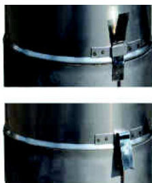
obr. 9 Zajištění komínových vložek proti posunutí, zahnutím plechu do oka
