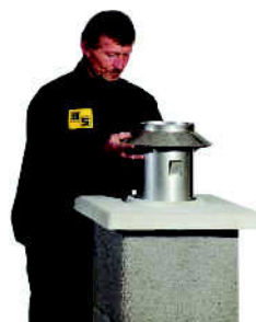
obr. 15 Montáž dilatačního zakončení
